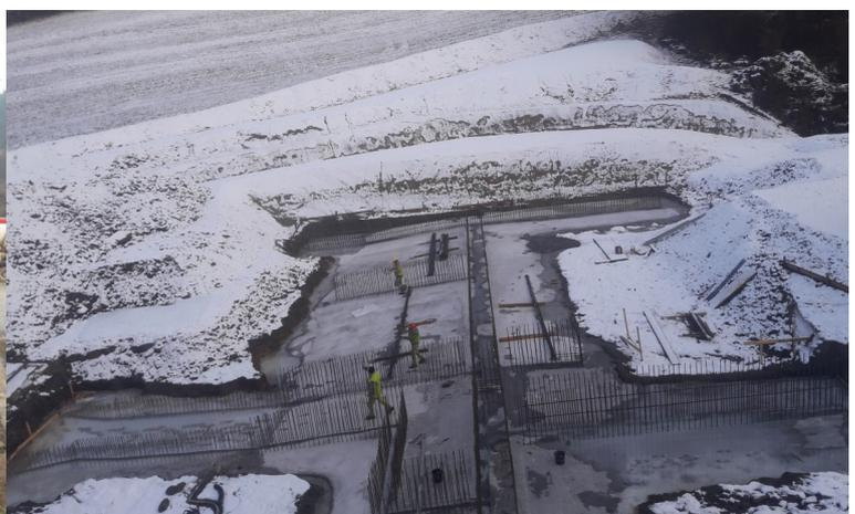
Hier entsteht das Fundament für die Betonmauer beim Rückhaltebecken Pulvermühlenbach, Unterleiten! Es wurden bereits 50 Tonnen Eisen verlegt und 665 m<sup>3</sup> Beton eingebaut. Die Arbeiten werden durch die Wildbach- und Lawinenverbauung GBL Oö. Nord in Auftrag gegeben und durchgeführt.
